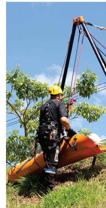
UTILIZAÇÃO COMO DESVIO DE ANCORAGEM (TRIPÉ EM PESCANTE).
